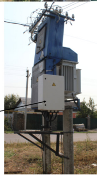
Фото- СМОНТИРОВАННЫЙ ЩИТ УСБОТ-ЭМ(К) НА ТП «ВЕРХНЯЯ ХАВА» филиал ПАО «Россети Центр»-«Воронежэнерго»
