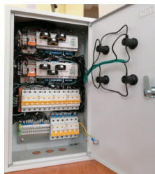
Фото щита УСБОТ для двухтрансформаторной подстанции с двумя устройствами УСБОТ-ПК(К)
