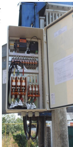
Фото щита УСБОТ для двухтрансформаторной подстанции с двумя устройствами УСБОТ-ПК(К)
