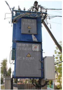
Фото- СМОНТИРОВАННЫЙ ЩИТ УСБОТ-ЭМ(К) НА ТП «ВЕРХНЯЯ ХАВА» филиал ПАО «Россети Центр»-«Воронежэнерго»
