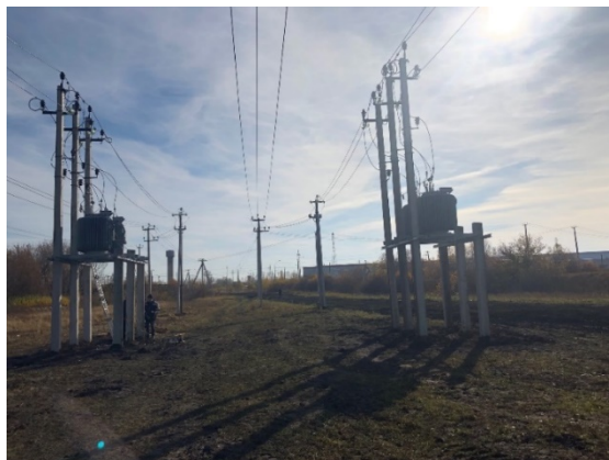
Рисунок 5 - В системе телемеханики предусмотрены функции измерения параметров сети и текущих параметров ПРН. Также есть возможно изменения уставок регулирования и перевода ПРН из автоматического режима регулирования в ручной.
