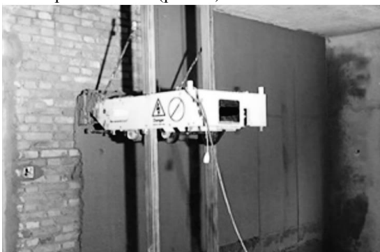
Рисунок 5 – Робот для разравнивания раствора на стенах
