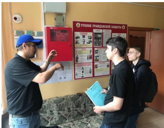
Студенты направления подготовки Техносферная безопасность на практике по монтажу и обслуживанию систем противопожарной защиты
