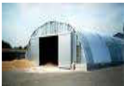
Рисунок 29 – Зернохранилище ангарного типа
