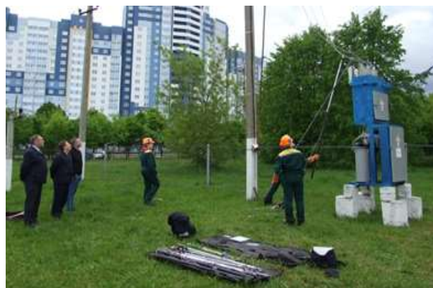
Выездное практическое занятие по программе «Электромонтер по ремонту и обслуживанию электрооборудования 3-го разряда»
